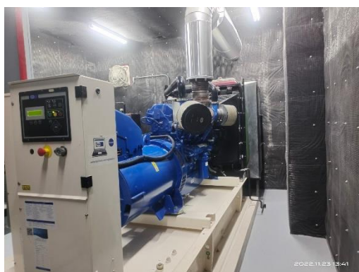
รูปที่ 42 เครื่องสำรองไฟ
