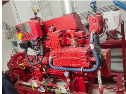
รูปที่ 17 เครื่องปั้มน้ำสำหรับดับเพลิง
